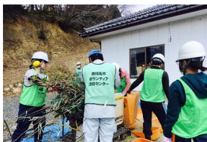
南相馬市小高区の被災者宅の裏山の雑木を伐採し粉砕機で細かくしている様子
