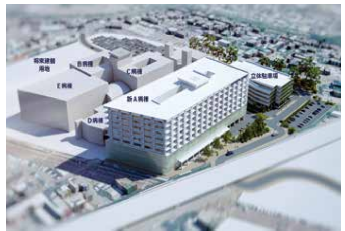
南西からの俯瞰
