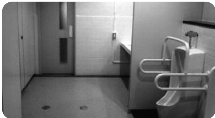
トイレ改修工事(医局棟・管理棟)
