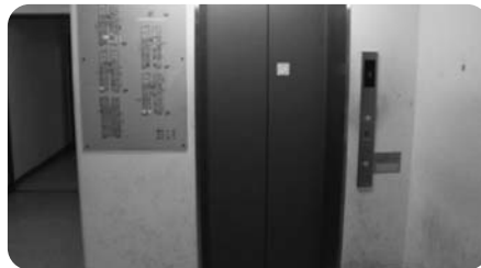
エレベーターリニューアル工事(基礎医学校舎)
