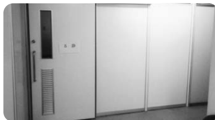
スライドドア化工事(病棟)
