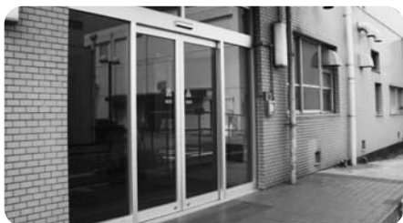
自動ドア化工事(基礎医学校舎)
